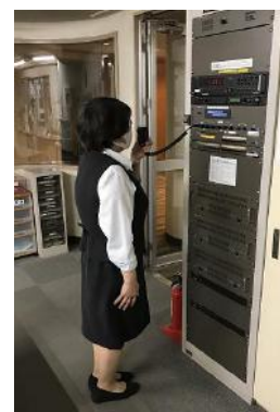
防災訓練（緊急一斉放送） 本社工場（R2.11）
