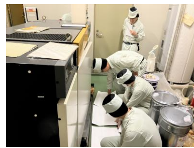
オイル漏洩緊急対応訓練(松任) (R7.8)
